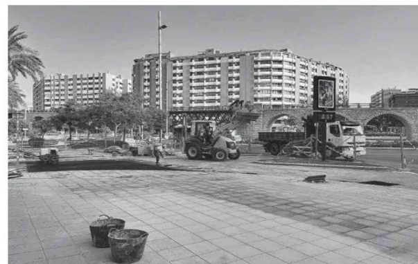
Finalización de los trabajos en la calle Ángel Jover. LA VOZ
