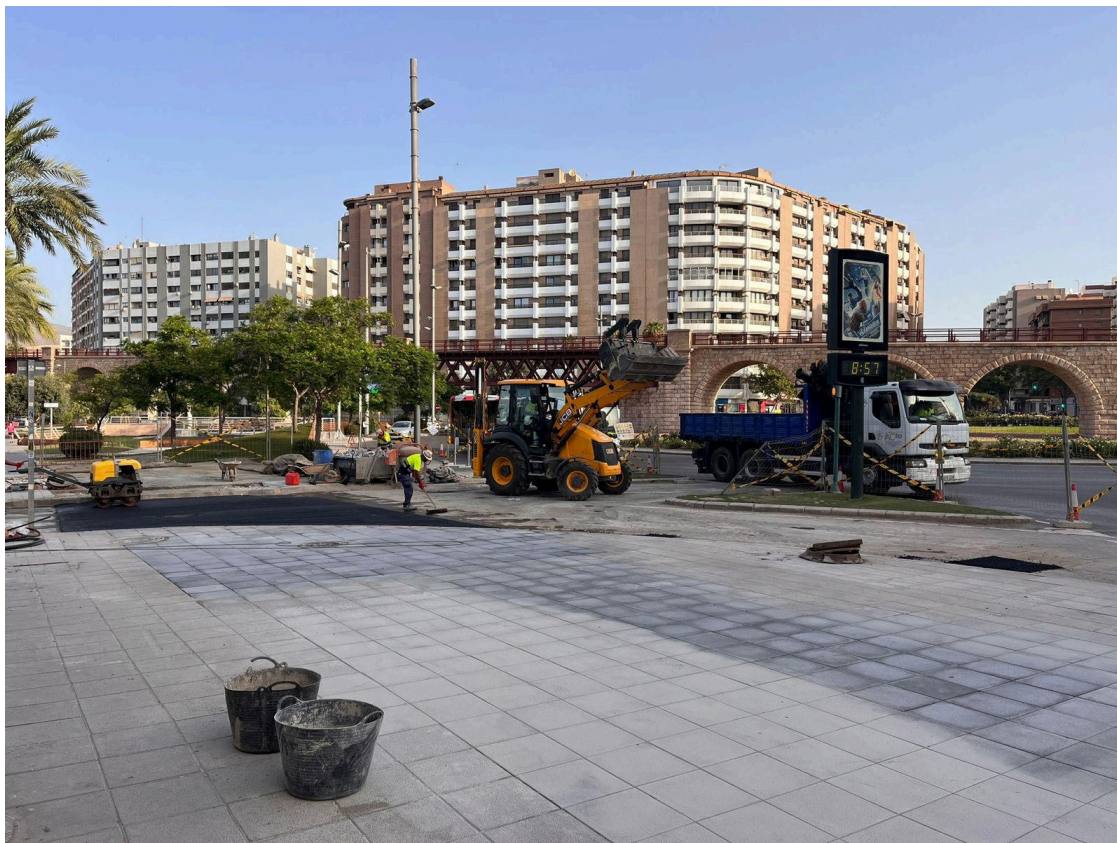
Obras del colector de la Avenida Cabo Gata. / D.A.
