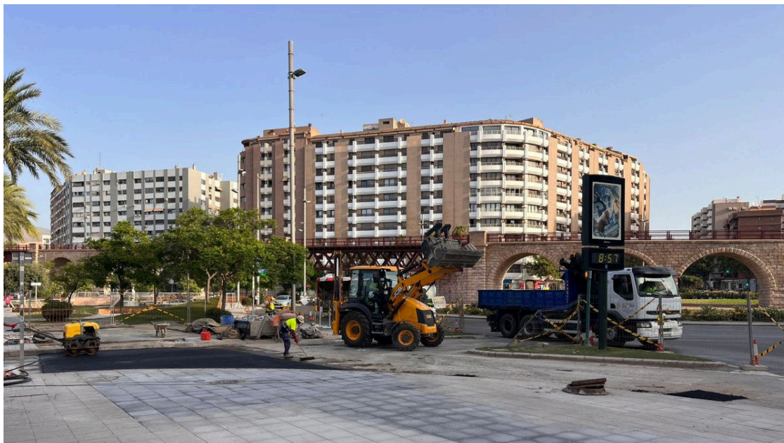
Finalización de las obras del colector de la Avenida Cabo de GataLa Voz
