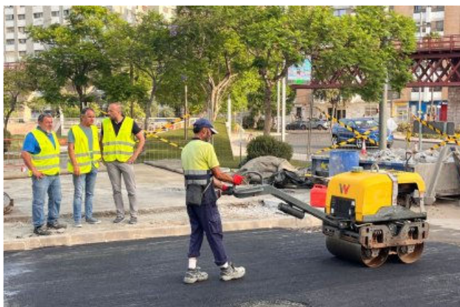
Visita de Juan José Segura a los trabajos durante la pavimentaciónLa Voz
